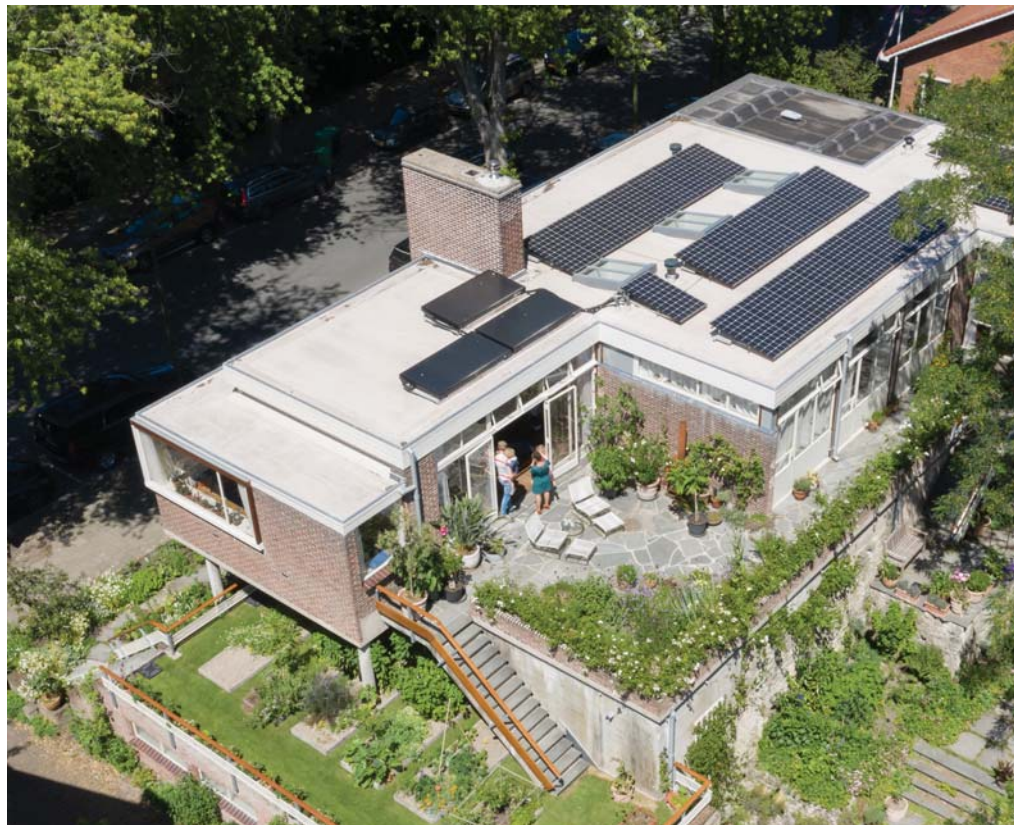
— Van bovenaf zijn de nieuwe zonnepanelen, zonnecollectoren en de witte dakhuid duidelijk zichtbaar.
